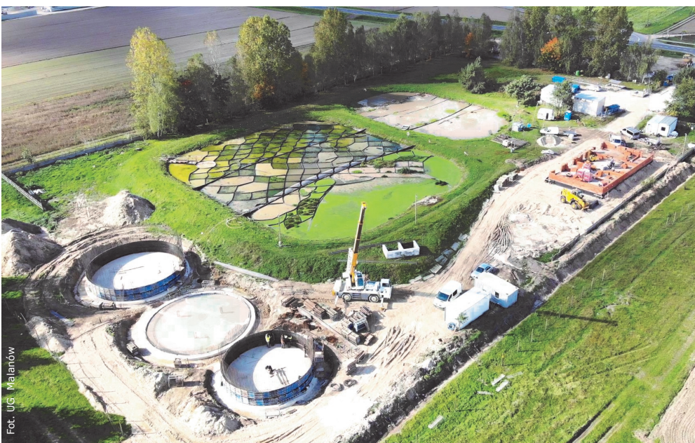
Oczyszczalnia ścieków w budowie
