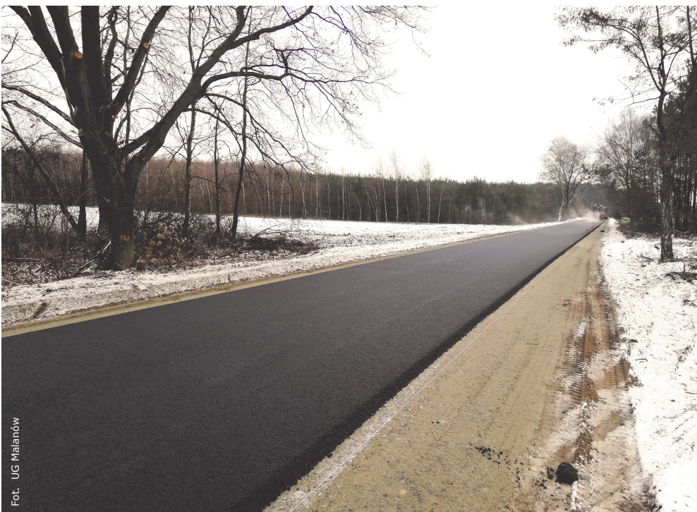
Przebudowana droga Skarżyn-Kolonia — Czachulec Stary
